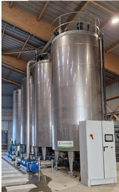
Armoire de commande
